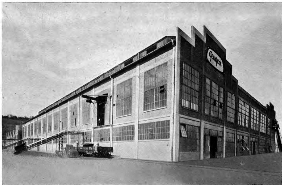
Fonderie Vue extérieure
