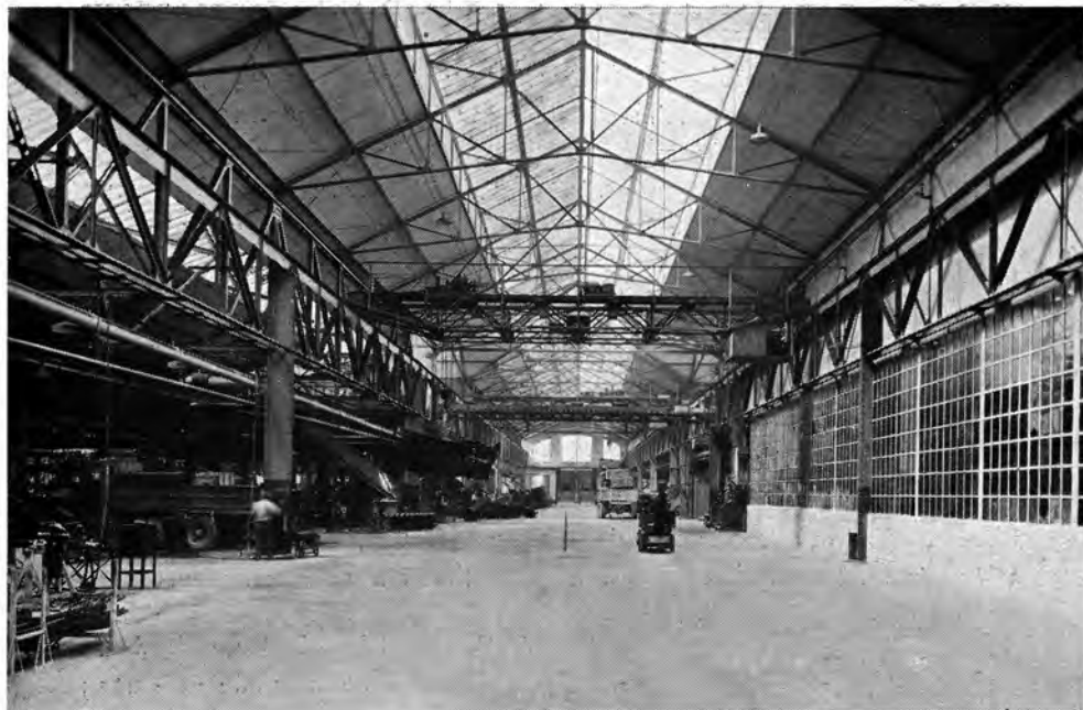
Usine de Mécanique Hall de manutention
