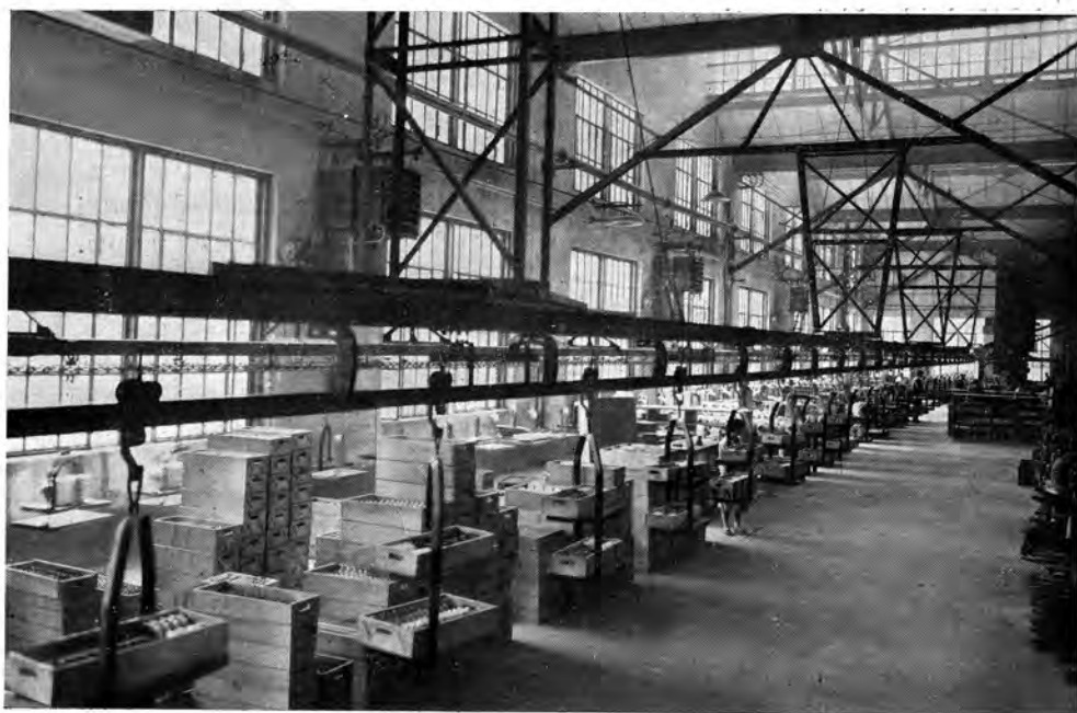
Fonderie Transporteur des noyaux
