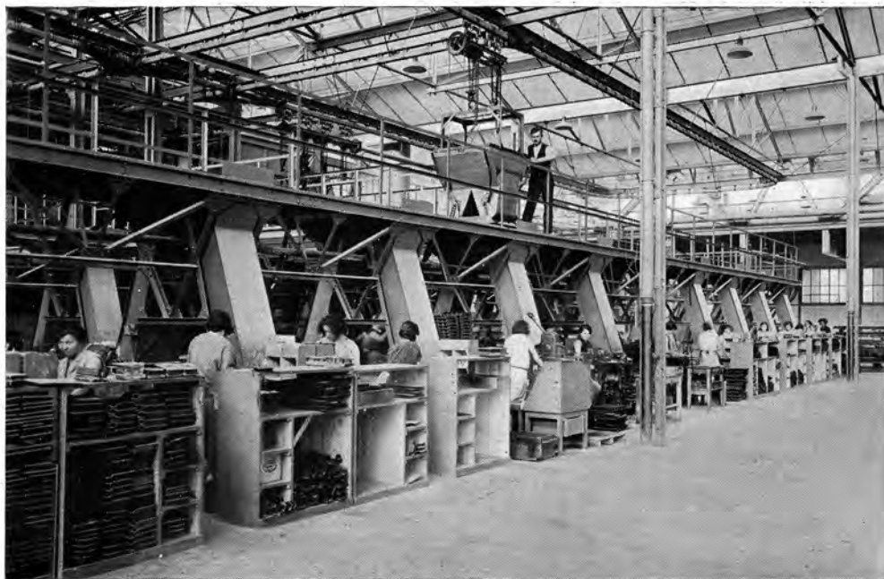
Fonderie Fabrication des noyaux
