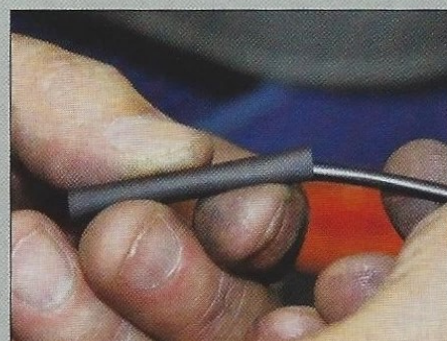
20 Pour isoler cette connexion et faire plus joli, introduire un bout de gaine thermorétractable.
